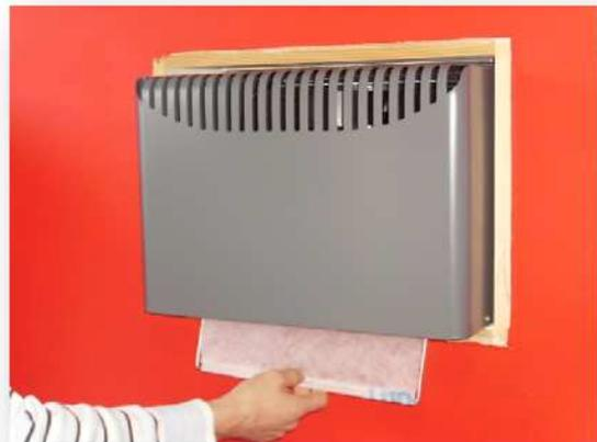
Wenn die Wand nicht zu stark ist, kann der Filter ohne Abnehmen der Abdeckhaube ausgewechselt werden. Dazu den Filter an der Aussparung unter dem Klimagerät anheben und nach unten herausziehen. Zum Einsetzen des neuen Filters umgekehrt vorgehen.
