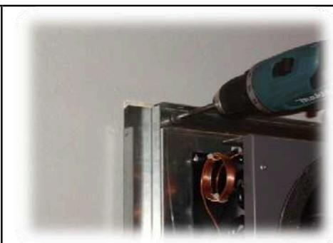
Zuerst oben 2 Schrauben mit deren Unterlegscheiben anbringen.
